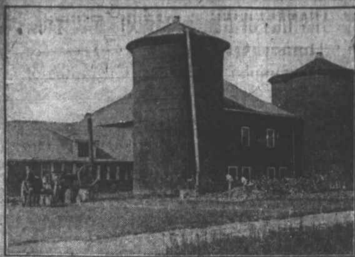
USING PERPENDICULAR PIPE TO FILL SILO.
